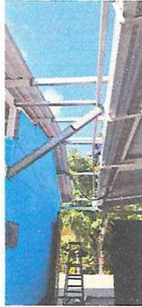
Foto 3: SUSTITUCIÓN DE LAMINA DEL TECHO
